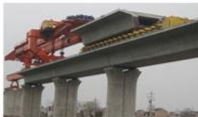
● 大型桥梁工程管理
